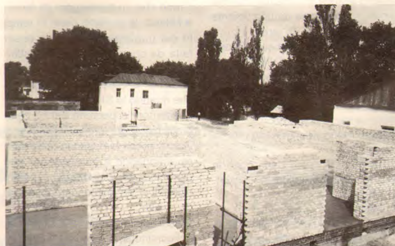
Lo stato dei lavori al termine del primo turno.
