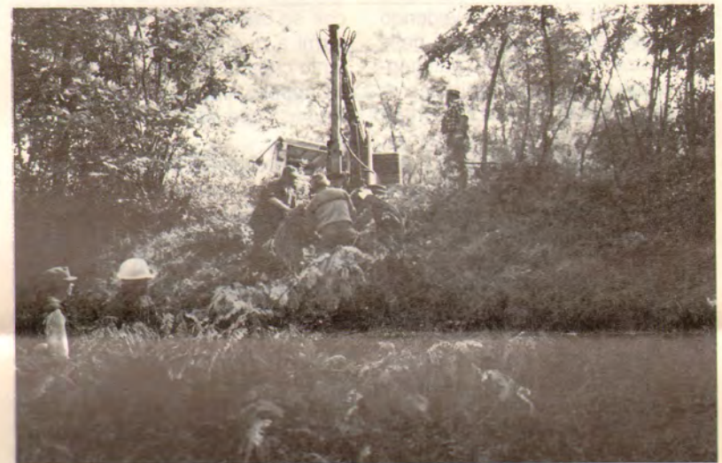
L'intervento sul torrente Rio Freddo.
